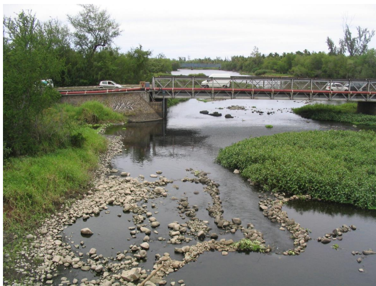
Photo n°5 – ECHELLE LIMNIMETRIQUE AU PONT METALLIQUE DE LA RN1 (SUR LA CULEE RIVE GAUCHE)
