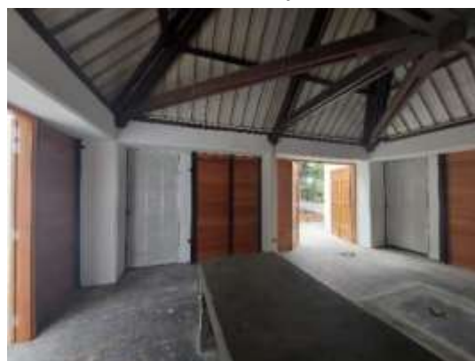
Intérieur de la base nautique
